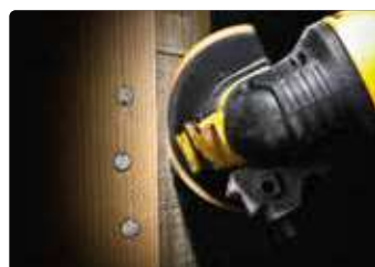
Cortar madeira de construção ▲
